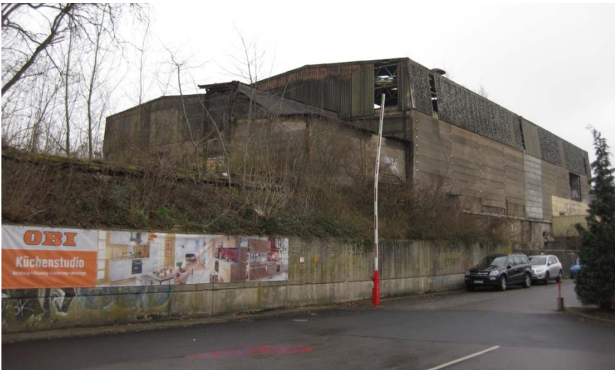
Abbildung 8 Köttgen-Gelände an der Zufahrt zum Baumarkt Obi im Gewerbegebiet West
