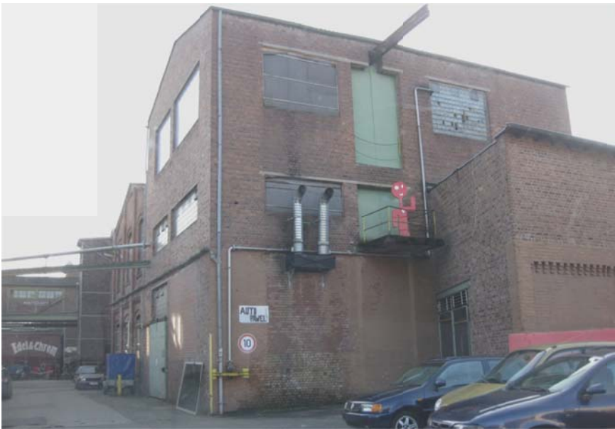
Abbildung 14 Ehemalige Papierfabrik Wachendorff im Gewerbegebiet Kradepohl
